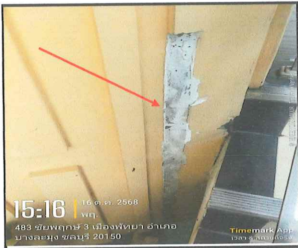
มีปูนหลุดจากผนังตรงบันไดไปสระว่ายน้ำ
